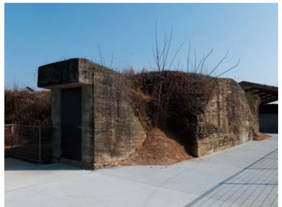
巨大防空壕跡(自力発電機室)
